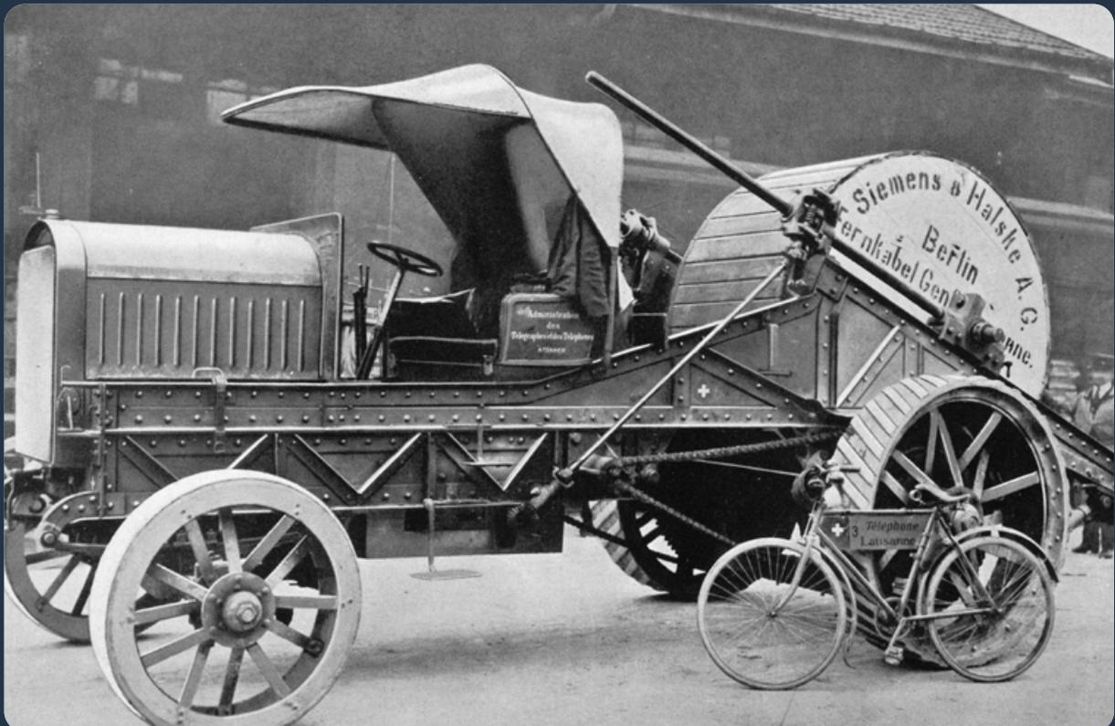
Kabeltransportwagen für die Verlegung des Fernmeldekabels auf der Strecke Genf - Lausanne, um 1920
