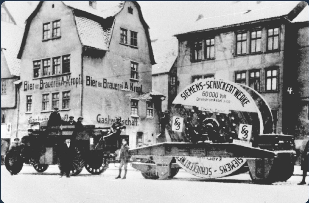
Transport eines 60 kV-Energiekabels in Kassel, 1922
